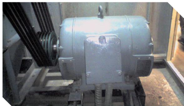
Ventilador Exhaustor IR2 origen del fallo en la ventilación.
