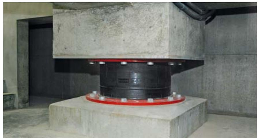
Construcción segura contra movimientos sísmicos: placas amortiguadoras en los cimientos
