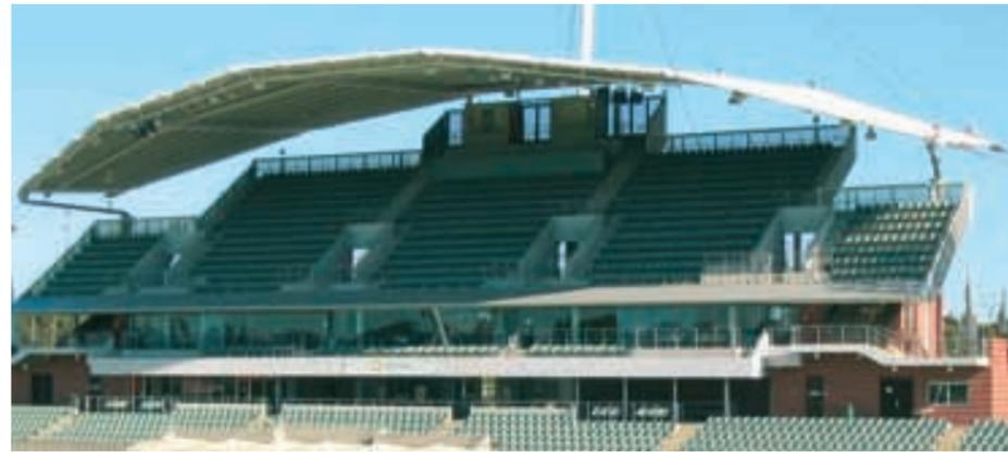
State Hockey Centre en Sydney: todos los puntos de fijación de los cables que tensan el techo están articulados con rótulas ELGES recubiertas con ELGOGLIDE®
